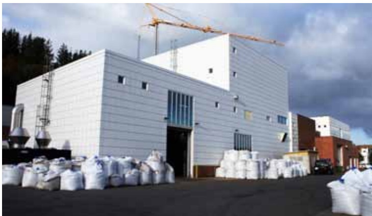
Resirkulering: Fabrikken på 600 kvadrat er basert på biorestar frå biogassproduksjon. 5 av 55 millionar kroner er Innovasjon Norge-støtte. IVAR investerer òg ein halv milliard kroner i betre slamkvalitet.
